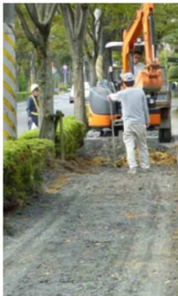
改修工事が進められる歩道
