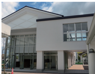
完成した新校舎
