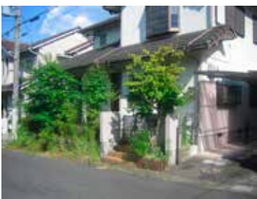
雑草が繁茂する作業前
