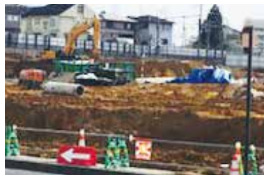
建設工事現場
