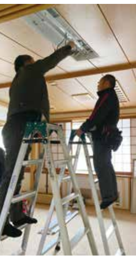
和室の蛍光灯交換工事
