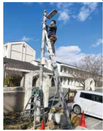
小学校正門前の設置工事
