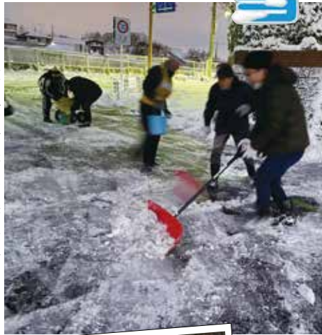
若草中央交差点付近の除雪作業
